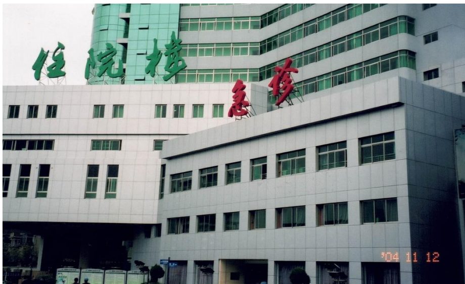
入院病棟と救急病棟
